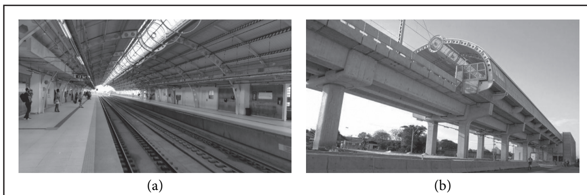
Figura 8 – Interior da estação Santo Afonso (a) e sua vista externa (b) Fonte: Os autores (2018).
